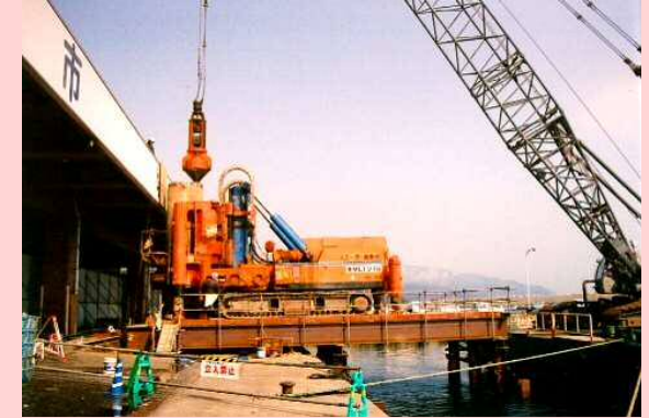
漁港内での場所打杭施工
