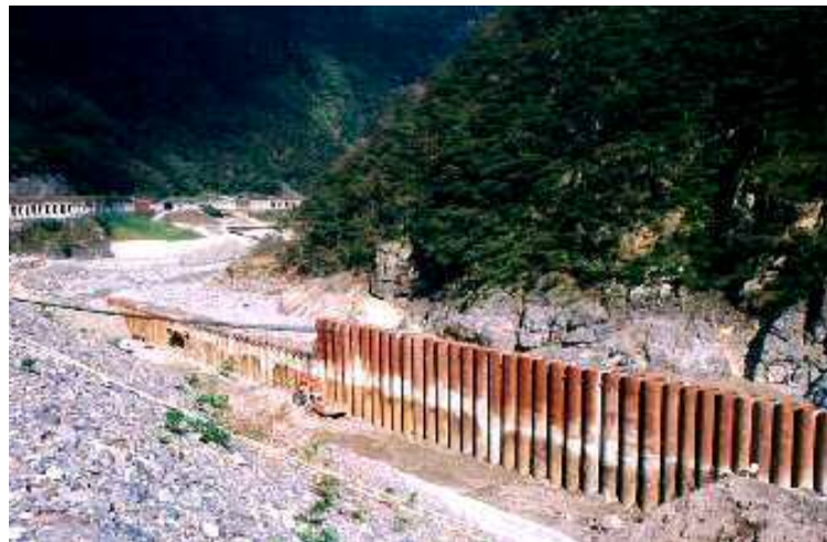
新潟県糸魚川市 姫川スリットダム砕石置換工 φ1500 掘削長32.0m
