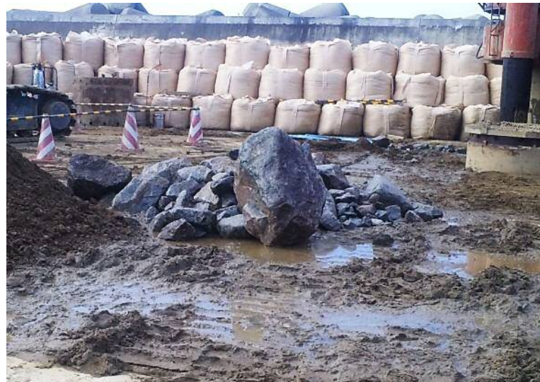
茨城県 常陸那珂火力発電所 護岸捨石撤去
