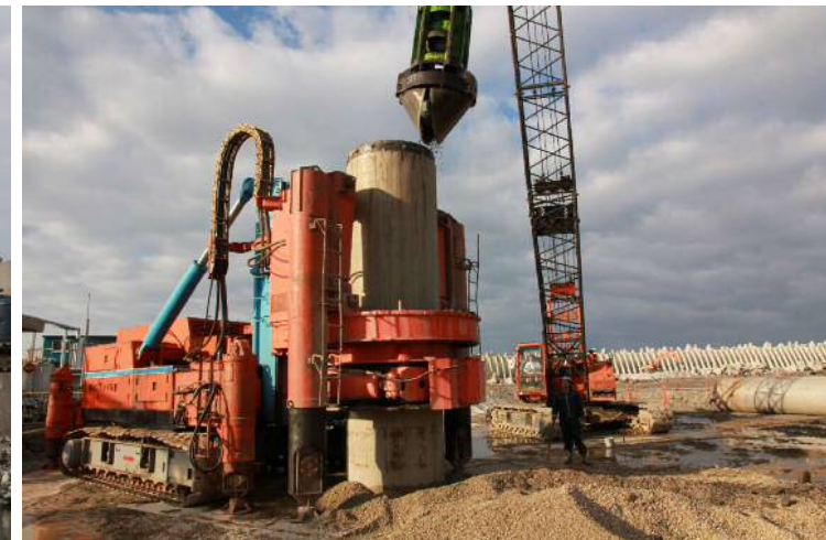
新潟県糸魚川市 姫川港護岸工事 砕石置換工
