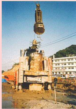
地中支障物撤去
