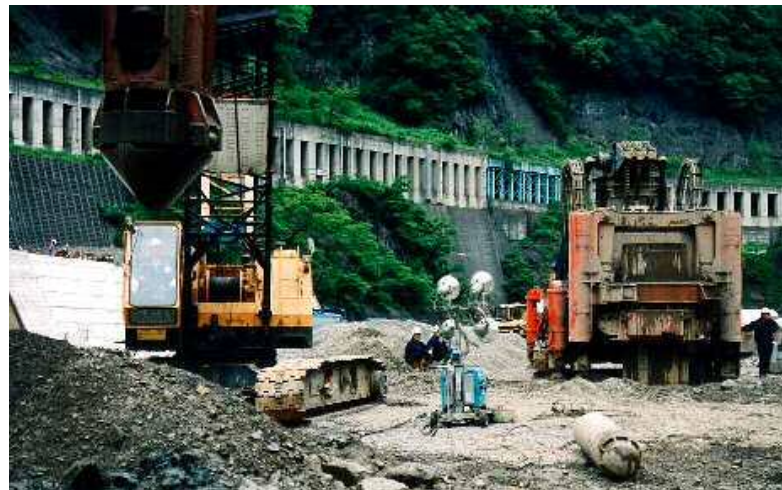
新潟県糸魚川市 姫川スリットダム砕石置換工 φ1500 掘削長32.0m
